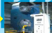
既設ボイラー
